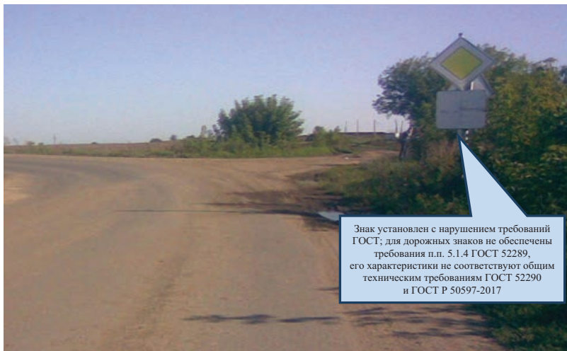
Рис. 14. Знаки установлены с нарушением требований ГОСТ Р 52289-2004, в том числе нарушены требования установки и взаимного размещения
