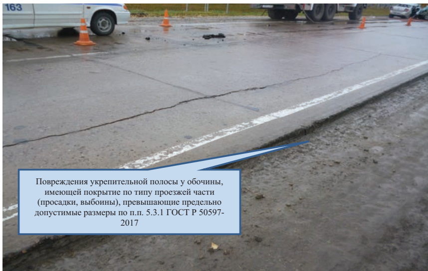
Рис. 11. Недостатки в содержании обочин автомобильных дорог и улиц, несоответствие требованиям ГОСТ Р 50597-2017
