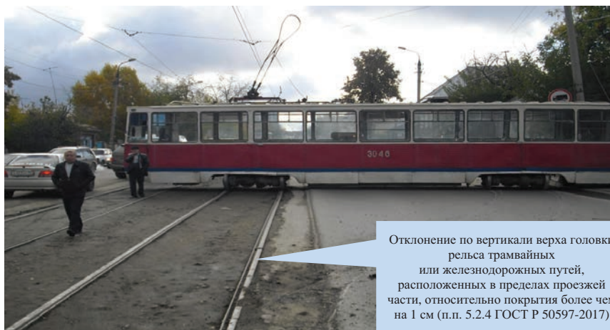
Рис. 36. Несоответствие трамвайных путей требованиям ГОСТ Р 50597-2017
