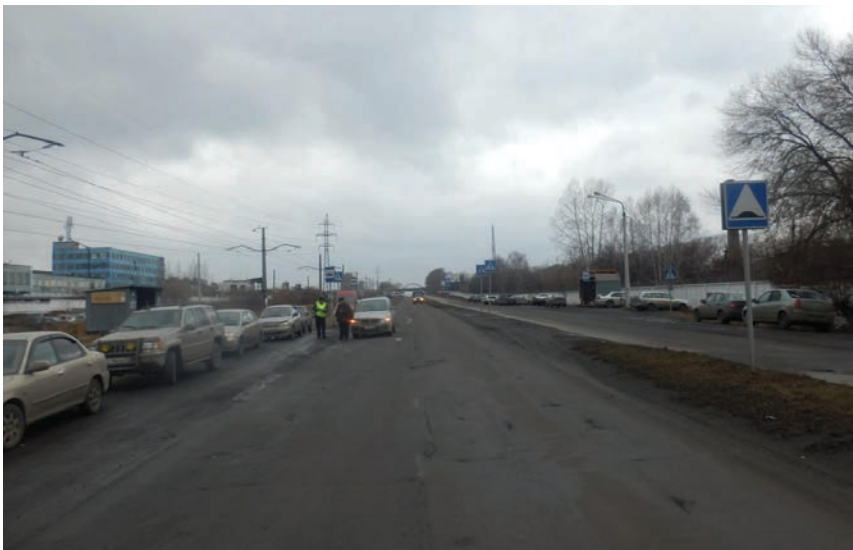
Рис. 29. Неудовлетворительное состояние разделительных полос автомобильных дорог и улиц, несоответствие требованиям ГОСТ Р 50597-2017
