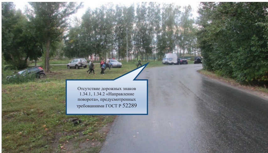
Рис. 6. Отсутствие с внешней стороны кривой на продолжении оси полосы дорожных знаков 1.34.1, 1.34.2 в соответствии с требованиями подп. 5.2.36 ГОСТ Р 52289
