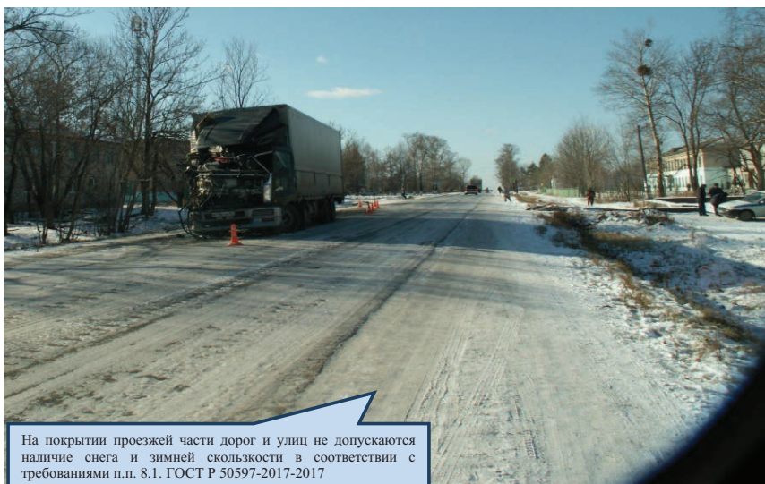
Рис. 8. Недостатки зимнего содержания автомобильных дорог и улиц, несоответствие требованиям ГОСТ Р 50597-2017
