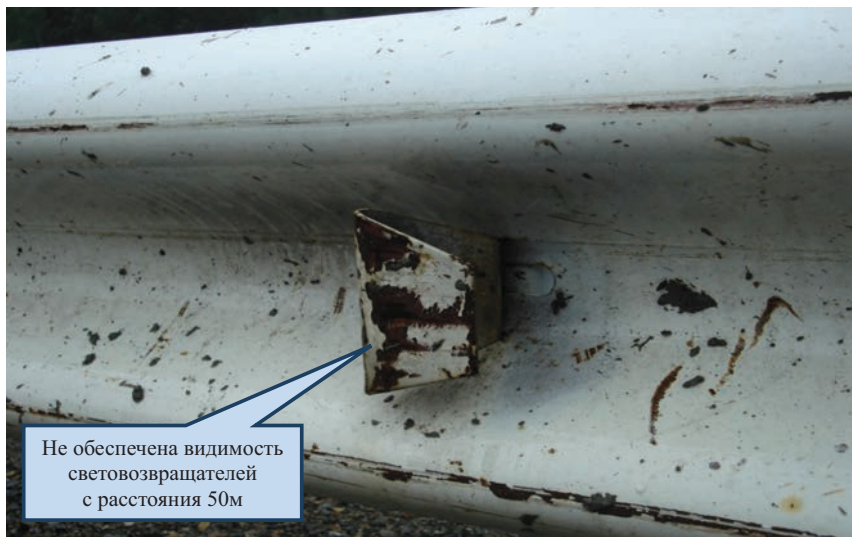
Рис. 33. Несоответствие световозвращателей требованиям ГОСТ Р 50597-2017
