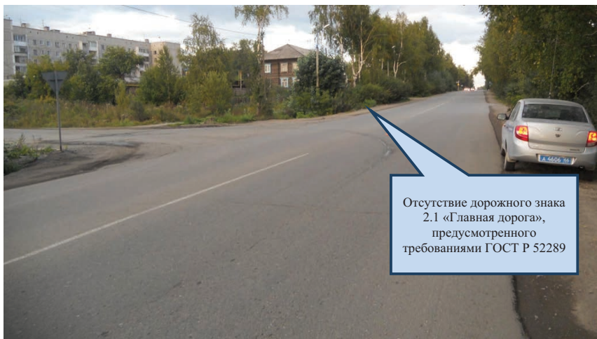
Рис. 7. Отсутствие перед перекрестком дорожного знака 2.1 «Главная дорога» в соответствии с требованиями подп. 5.3.2 ГОСТ Р 52289
