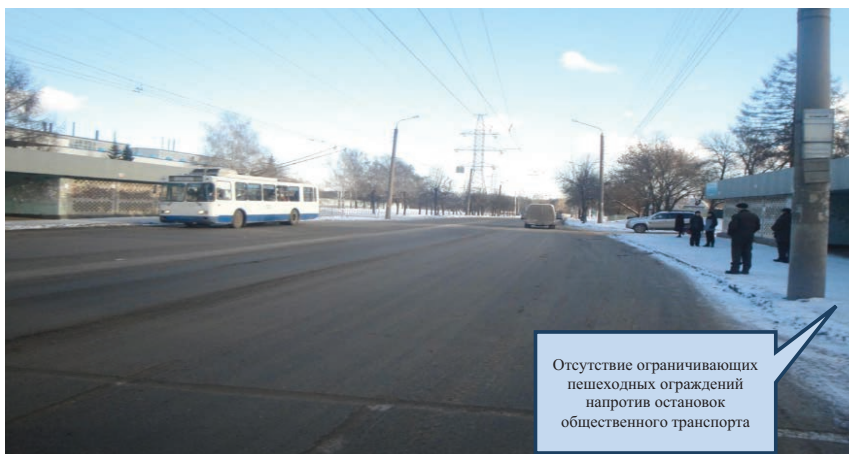
Рис. 13. Отсутствие удерживающих и ограничивающих пешеходных ограждений в необходимых местах по подп. 8.1.27–8.1.28 ГОСТ Р 52289, по подп 4.5.1.9, 4.5.2.6 ГОСТ Р 52766
