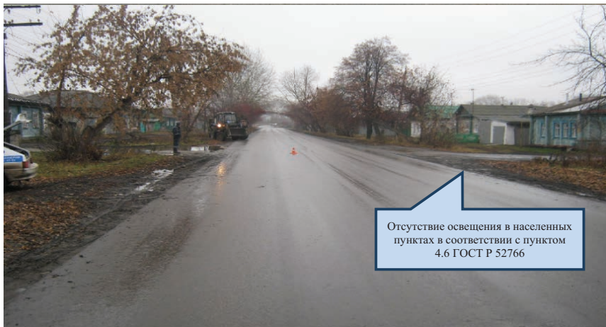
Рис. 12. Отсутствие освещения в необходимых местах в соответствии с пунктом 4.6 ГОСТ Р 52766
