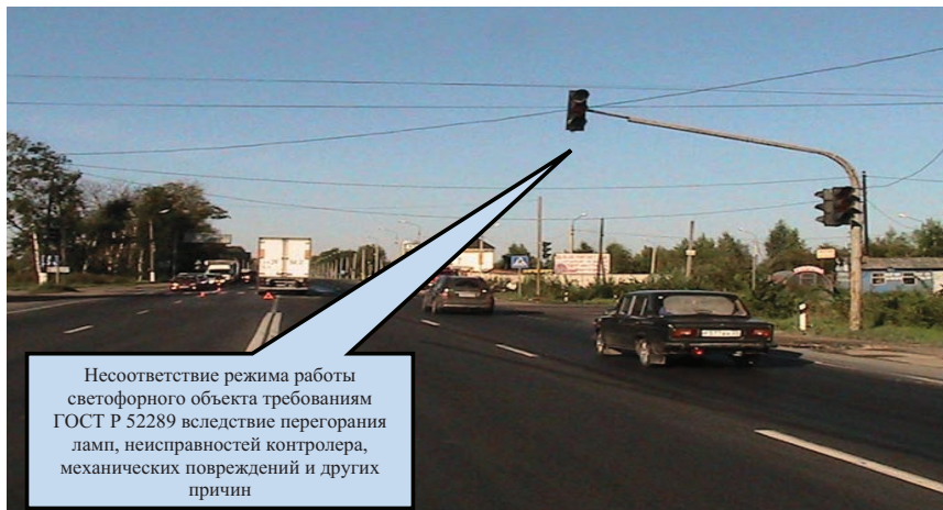
Рис. 25. Несоответствие режима работы светофорного объекта требованиям ГОСТ Р 52289 вследствие перегорания ламп, неисправностей контроллера, механических повреждений и других причин
