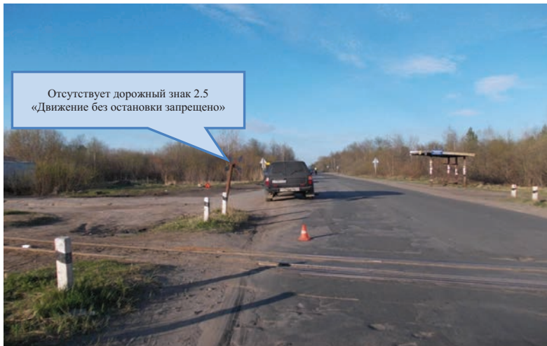
Рис. 35. Отсутствие на железнодорожном переезде необходимых дорожных знаков
