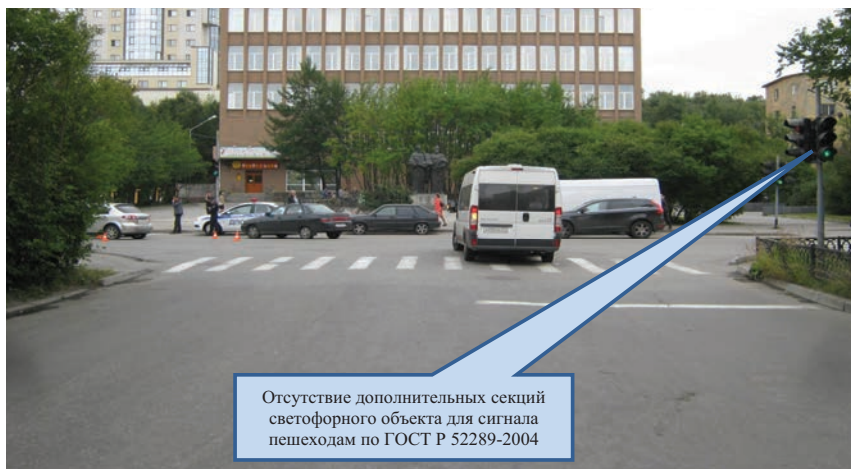
Рис. 34. Несоответствие светофора требованиям ГОСТ Р 52289
