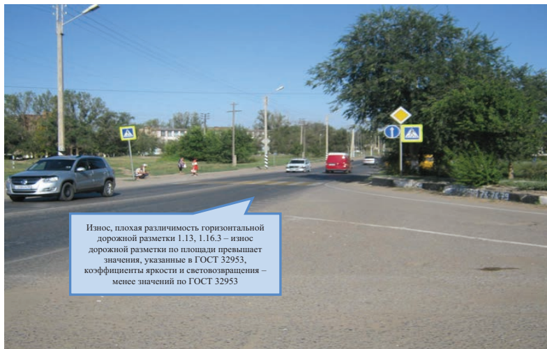
Рис. 4. Отсутствие на проезжей части дороги линий горизонтальной разметки в соответствии с требованиями подп. 6.2.2 ГОСТ Р 52289
