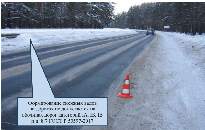
Рис. 24. Сужение проезжей части из-за формирования снежных валов на дороге
